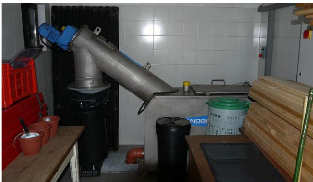
*Figura 28 - Griglia di trattamento delle acque di scarico, Rifugio Dorigoni*
