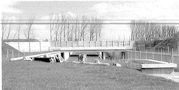
Passaggio fauna selvatica: quando gli habitat sono separati da strade o altre infrastrutture, possono essere costruiti, per ripristinare i collegamenti, sottopassaggi o attraversamenti come quelli per le persone
