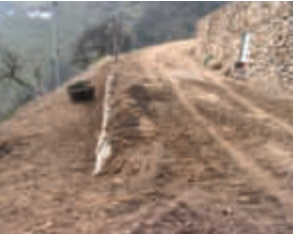
4 | Stützmauer aus Naturstein und Straßenbegrenzung aus Lärchenholz | Muri di sostegno in pietra e guardavia in legno di larice
