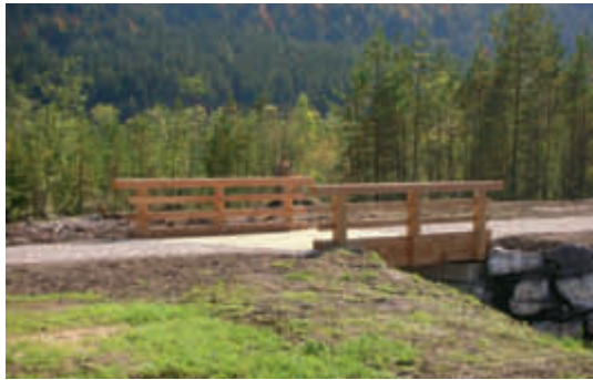
3 | Weißenbach: Feldwegbrücken werden nach Möglichkeit mit heimischem Holz errichtet | Weißenbach: i piccoli ponti di campagna vengono costruiti per quanto possibile con legname locale
