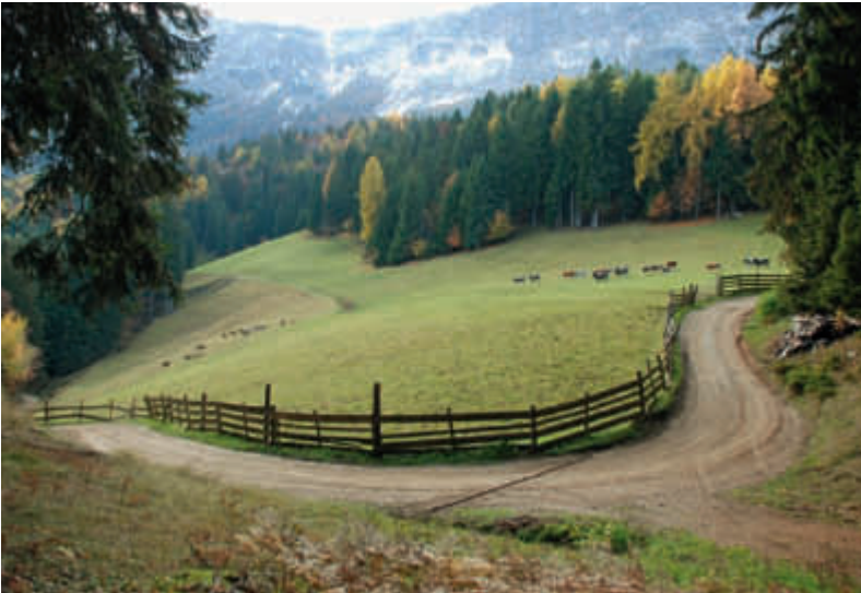
1, 2 | Der stark beanspruchte Walderschließungsweg | La strada forestale molto sollecitata
