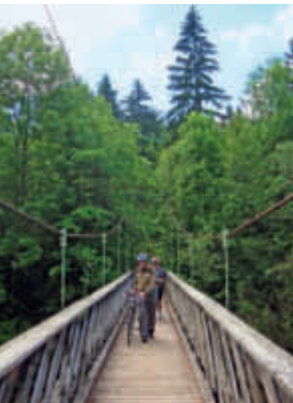
6, 7, 8, 9 | Radwegbrücke über den Zinkenbach; die alte Hängebrücke und der neue Träger aus Viereckrahmen | Ponte ciclabile sul torrente Zinken; il vecchio ponte sospeso e la nuova struttura a traliccio a maglia rettangolare
