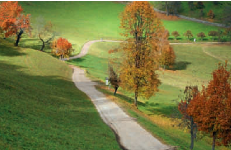
5 | Die Wegtrasse, eingebettet in die vorhandene Topographie | Il tracciato della strada inserito nella topografia esistente
