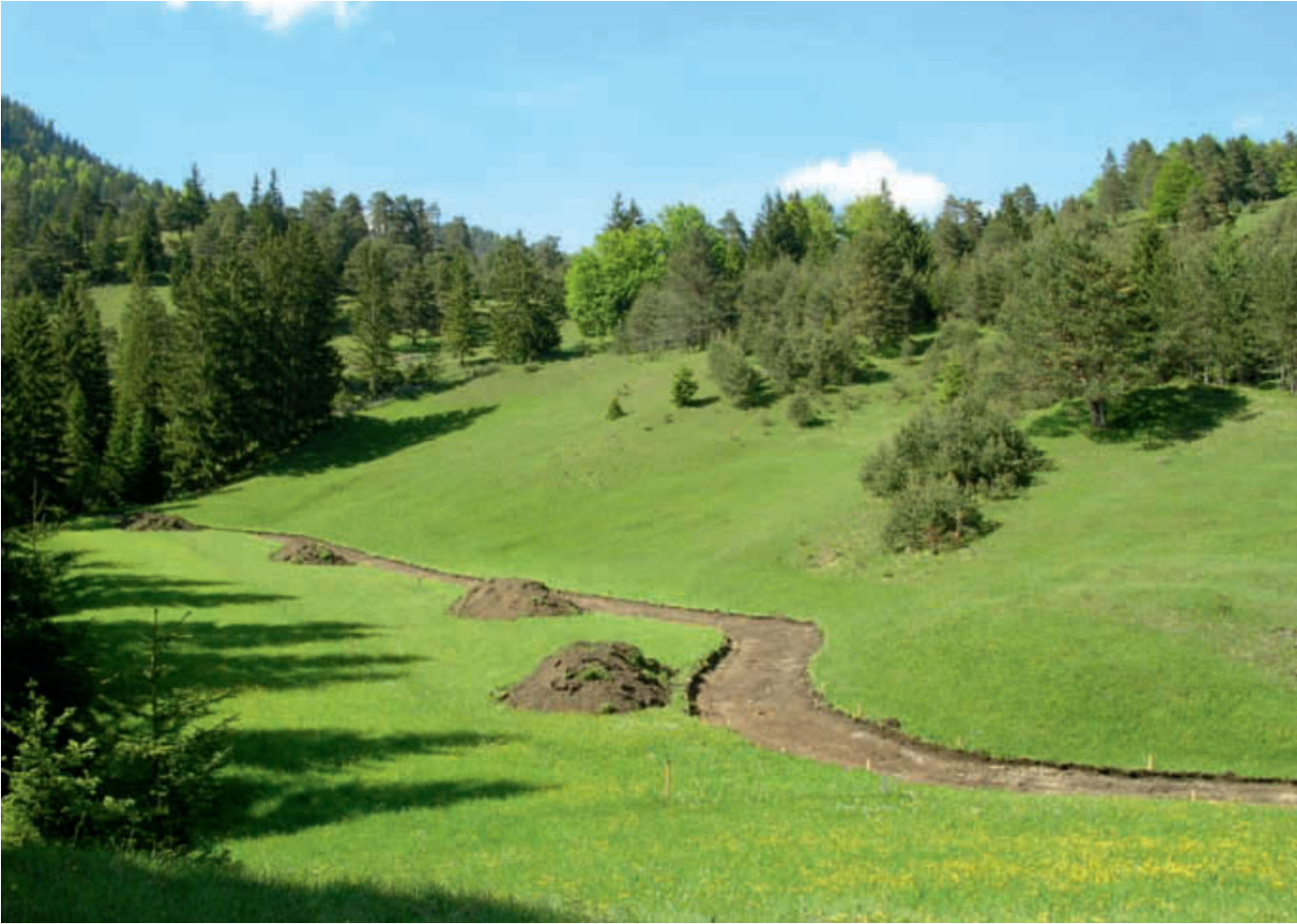
1 | Versuchsstrecke: Der Humus wurde von der künftigen Wegtrasse abgetragen | Tratto sperimentale: l'humus viene rimosso dalla futura carreggiata
