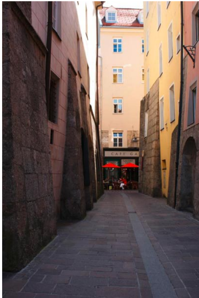
Erdbebenmauern Altstadt (Aufnahme August 2008)
