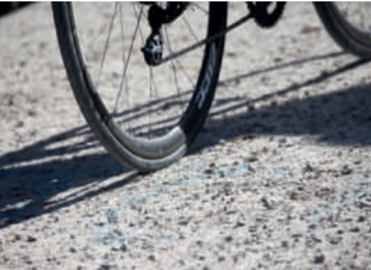
2 | Wassergebundene Wegedecke mit hydraulischen Binde- und polymeren Zusatzmitteln | Manto stradale stabilizzato con l’ausilio di leganti idraulici e additivi polimerici
