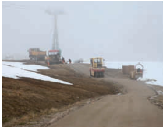
4 | Ausbringen der Verschleißschicht mit Fertiger und Verdichtung mit Walze | Statura del manto d'usura con la finitrice e costipamento col rullo
