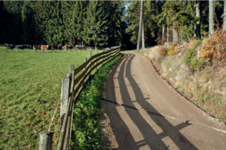
3, 4, 5 | Verfestigung der Verschleißschicht durch polymere Bindemittel | Consolidamento del manto d'usura con legante polimerico
