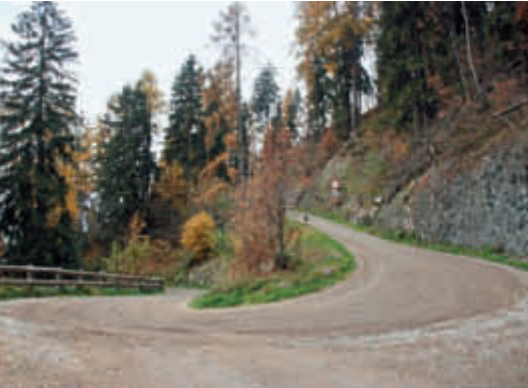
4 | Stützmauer aus Naturstein und Straßenbegrenzung aus Lärchenholz | Muri di sostegno in pietra e guardavia in legno di larice
