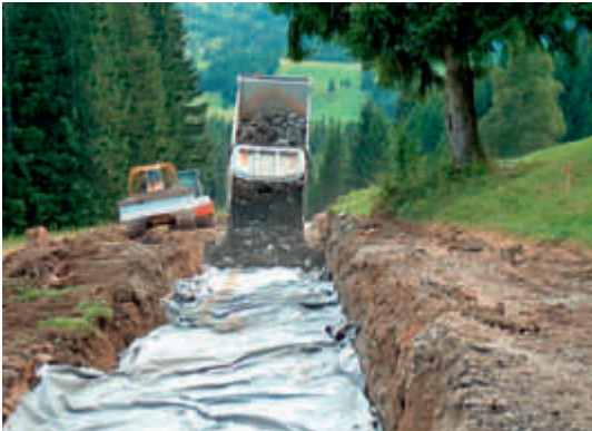
2, 3 | Die Stabilisierung des Weges durch Einbringen von Vlies und Erhöhung des Unterbaues | La stabilizzazione della strada tramite la posa di tessuto-non-tessuto e la maggiorazione del sottofondo
