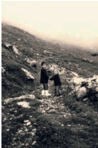
13a | Alpweg „In der Enge“ unmittelbar nach Fertigstellung | Sentiero per l'Alpe "In der Enge" subito dopo l'ultimazione
