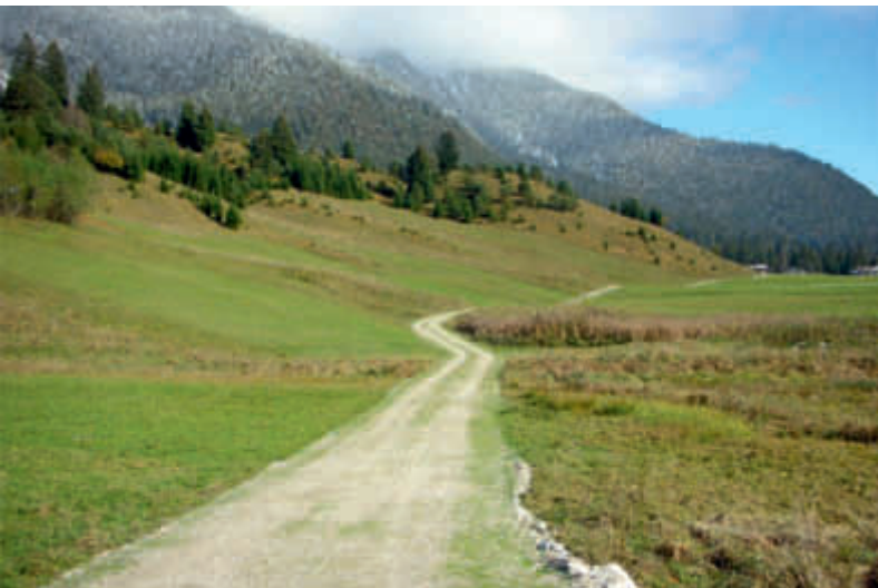
7 | Weg beim Moosberg: bereits kurz nach Bauende gut in die Landschaft integriert | La strada campestre nei pressi di Moosberg già ben integrata nel paesaggio poco dopo la fine dei lavori
