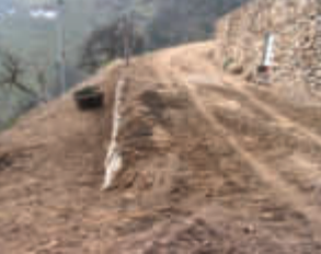
4 | Stützmauer aus Naturstein und Straßenbegrenzung aus Lärchenholz | Muri di sostegno in pietra e guardavia in legno di larice
