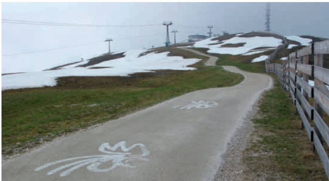
3 | Die Verwendung von örtlich gewonnenem Material trägt zur landschaftlichen Einbindung der Straße bei | L'uso di materiale ricavato da cave di prestito contribuisce all'inserimento paesaggistico della strada
