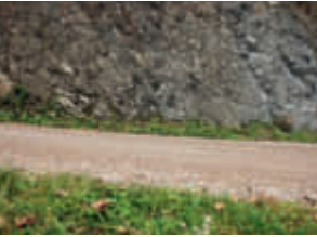
5, 6, 7, 8 | Die Verwendung von örtlich gewonnenem Material trägt zur landschaftlichen Einbindung der neuen Straße bei | L'uso di materiali rinvenuti in loco contribuisce all'inserimento paesaggistico della nuova strada
