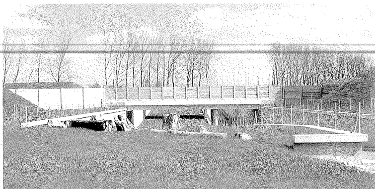
Wilddurchlass: Wenn Lebensräume durch Straßen oder andere Infrastruktureinrichtungen abgetrennt sind, können Unter- oder Überführungen ebenso wie für den Menschen gebaut werden, um Verbindungen wiederherzustellen.
